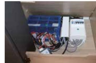
Die Elektrozentrale mit den 230 und 12 Volt Sicherungen ist im Kleiderschrank untergebracht
